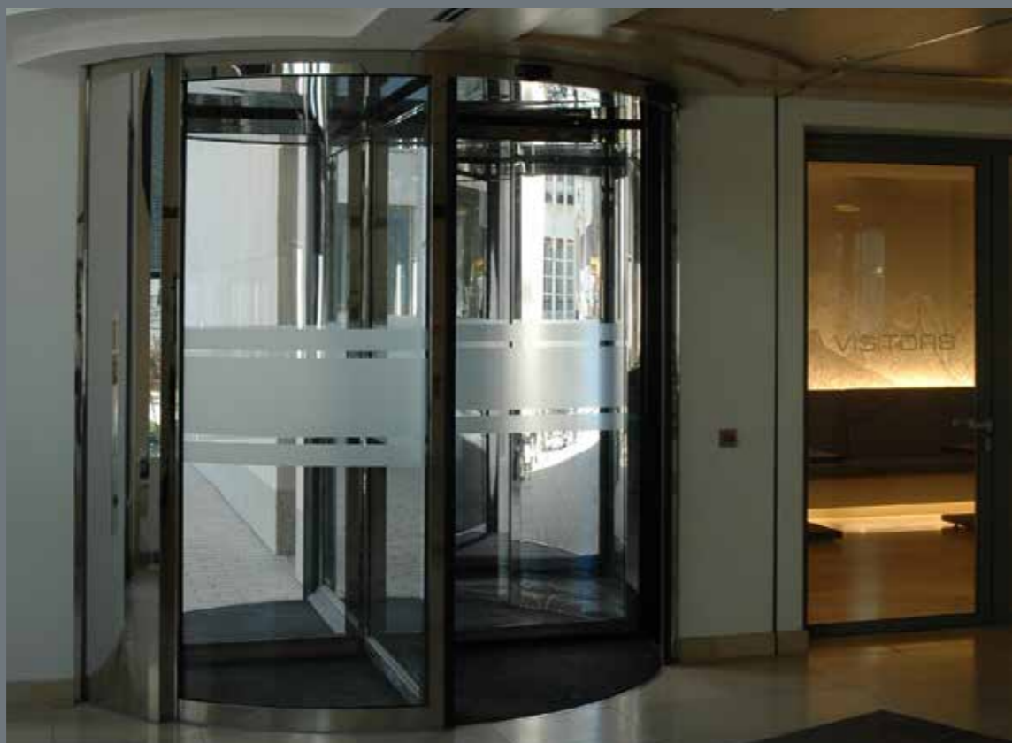
Raumbezeichnung in Etchedglassfolie: Kennzeichnung und Durchlaufschutz zugleich. Sicherung der Drehtüre mit Balkenmuster.
